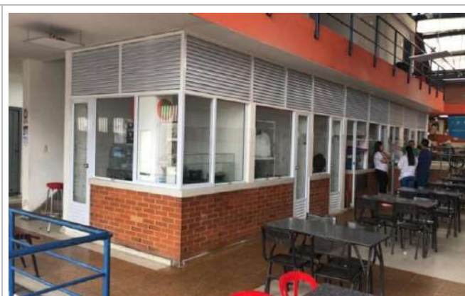
Fotografía N°2 Después de la hermetización de las cocinas PMD Fontibón
