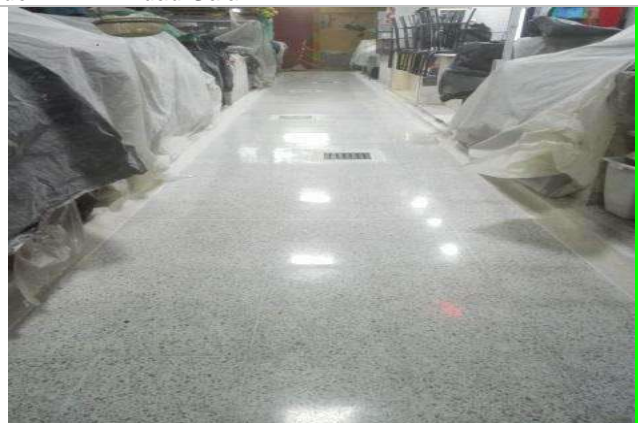
Fotografía N° 6 Después pasillo No. 6 de PMD 7 de agosto
