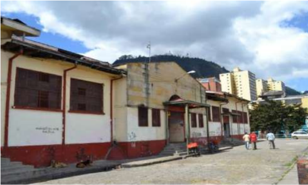
Fotografía N°1 antes Fachada principal y plazoleta estado actual.
