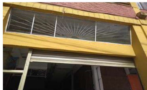
Fotografía N° 10 Mantenimiento y cambio de puerta cortinas.
