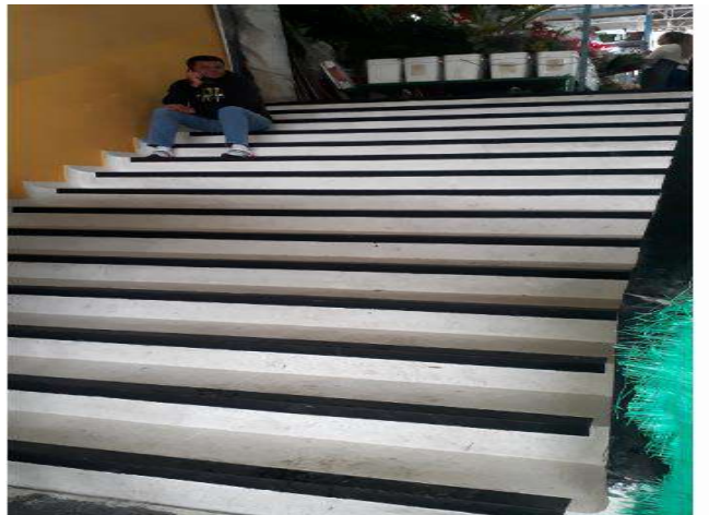
Fotografía N° 14 Después pisos zona escaleras PMD Restrepo.
