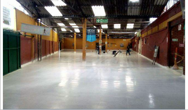
Fotografía N° 16 Después pisos zona mercado campesino PMD Las Ferias.
