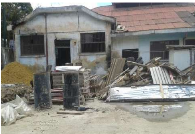
Fotografía N°1 Antes Fachada y pisos de plazoleta interior costado oriental PMD La Concordia.
