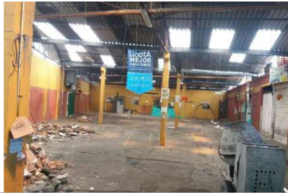
Fotografía N° 15 Antes pisos zona mercado campesino PMD Las Ferias.
