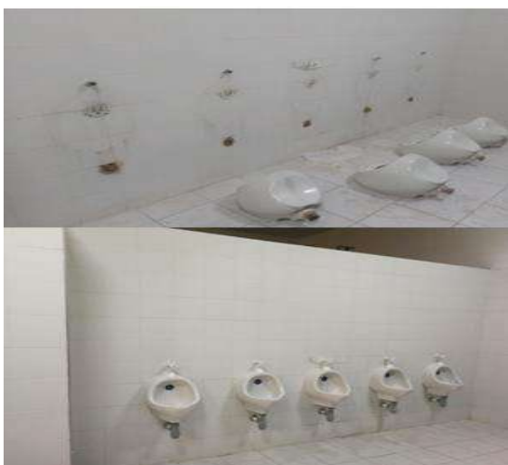
Fotografía N° 3 Cambio orinales baños Sur.
