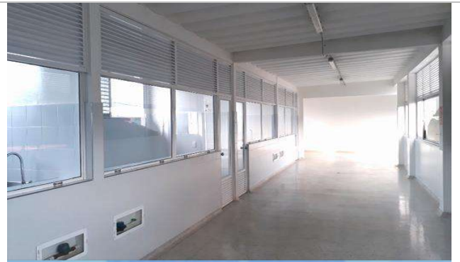
Fotografía N° 12 Después Cocinas segundo piso PMD 12 de octubre
