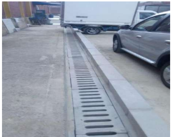
Fotografía N°20 Después zona Cárnicos Cárcamo para recolección de aguas servidas Quirigua
