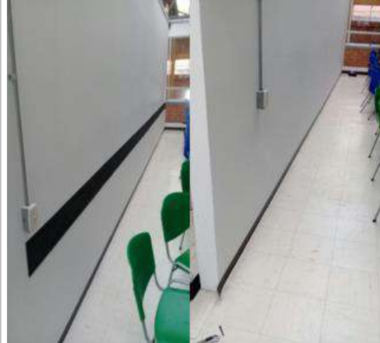
Fotografía N° 6 Instalación de protectores y guardaescoba.
