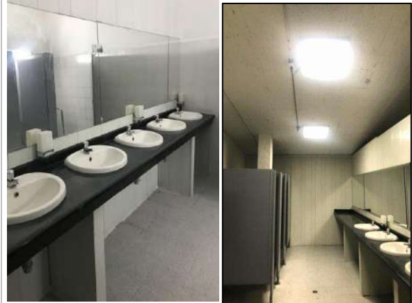
Fotografía N° 12 Baños centrales estado final.
