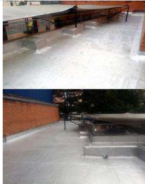
Fotografía N°2 Aseo e Impermeabilización de cubierta.
