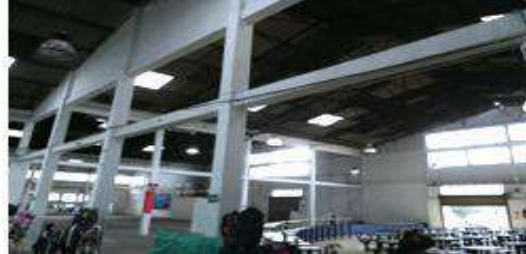
Fotografía N° 6 Retiro malla angeo en plazoleta.
