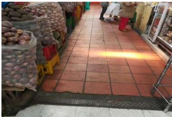
Fotografía N° 5 Antes pasillo No. 6 de PMD 7 de agosto
