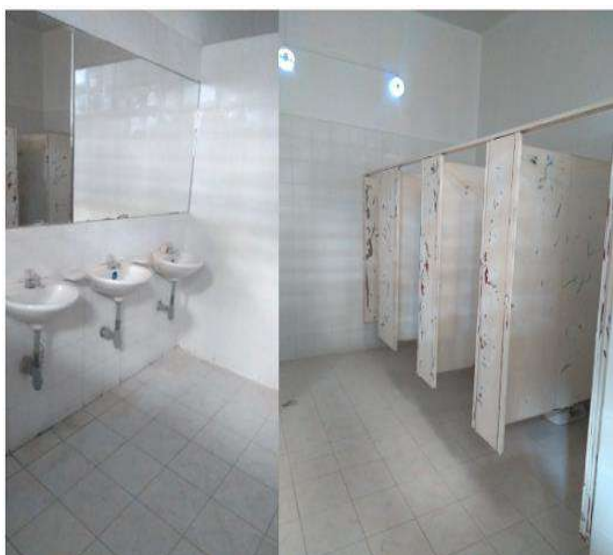
Fotografía N°1 Baños Sur estado inicial.
