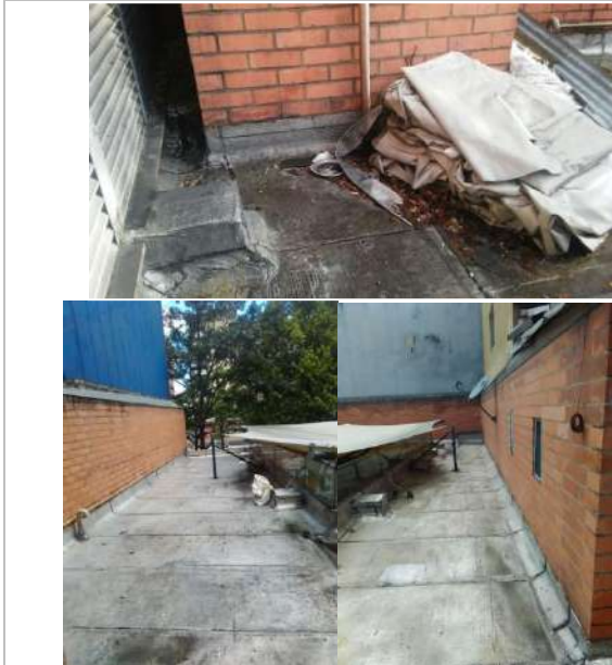
Fotografía N°1 Cubierta antes de intervenir
