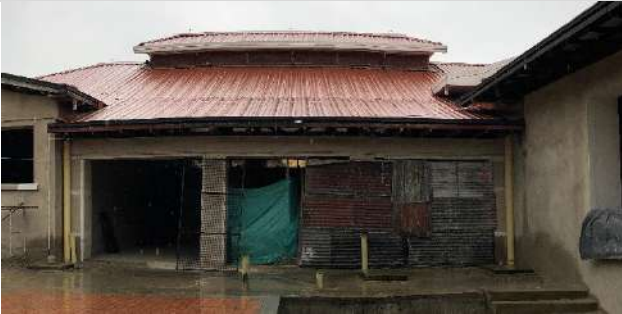
Fotografía N°7 antes zona plazoletas de comidas cocinas
