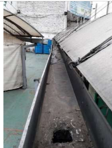
Fotografía N°2 Limpieza de canales.
