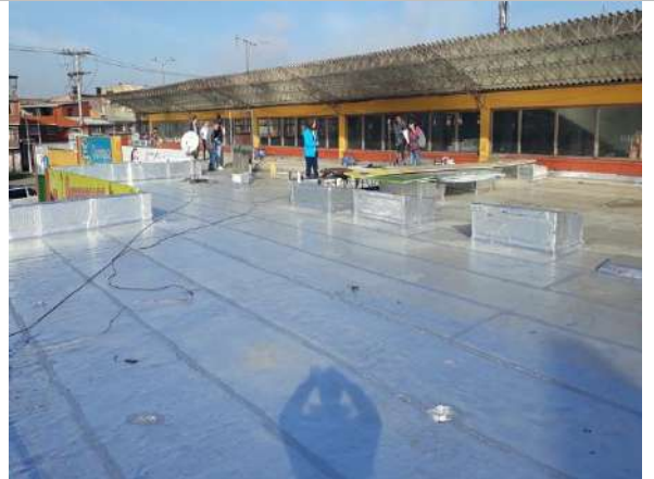
Fotografía N° 18 Después impermeabilización cubierta PMD Las Quirigua.
