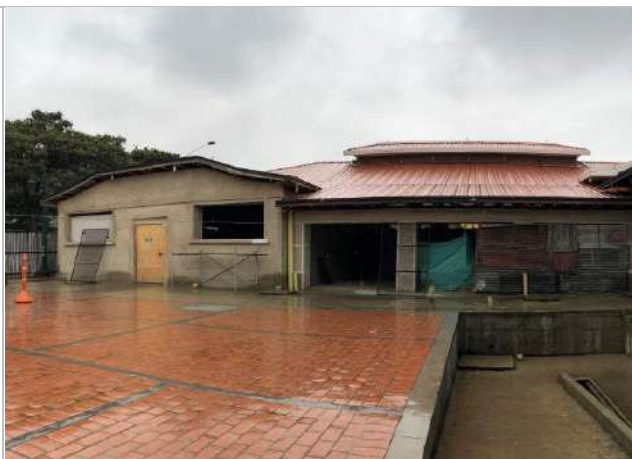
Fotografía N°2 Después Fachada y pisos de plazoleta interior costado oriental PMD La Concordia.
