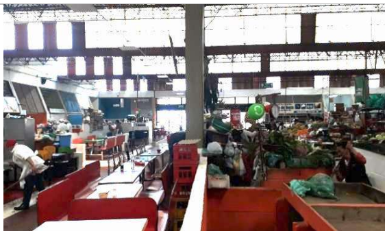
Fotografía N°7 Antes cocinas y pisos de PMD Kennedy
