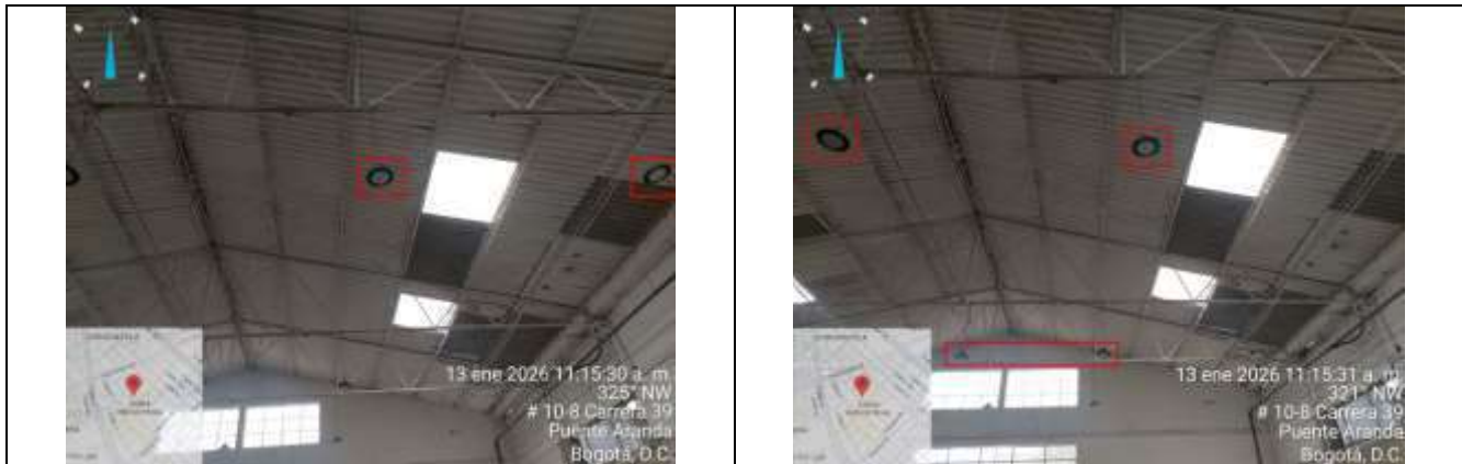
Fotografías No. 1 y 2. Instalación de luminarias ahorradoras en el Punto Comercial San Andresito de la 38
