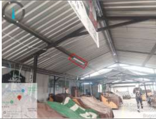
Fotografías No. 1, 2 y 3. Instalación de luminarias ahorradoras en el área campesina de la Plaza de Mercado 20 de julio
