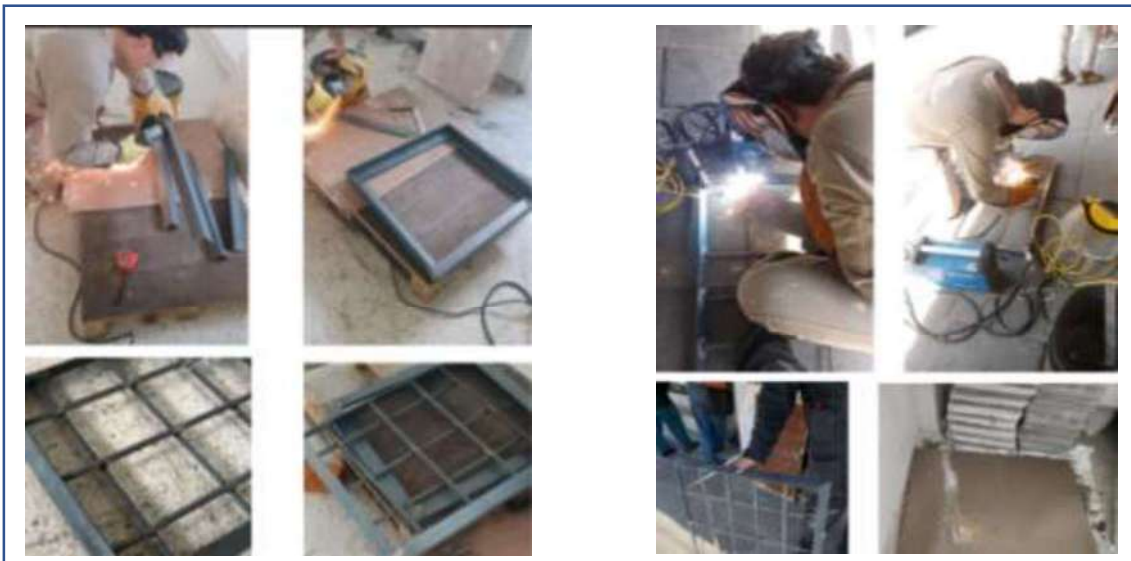
Figura 19. Registro fotográfico del operario ayudante haciendo trabajos de soldadura.
