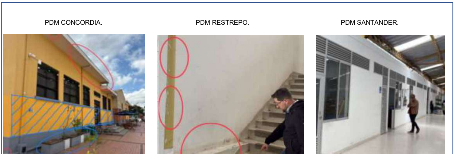
Figura 21. Labores de pintura identificadas en las visitas programadas.
