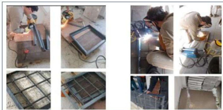
Figura 23. Registro fotográfico del operario ayudante haciendo trabajos de soldadura.
