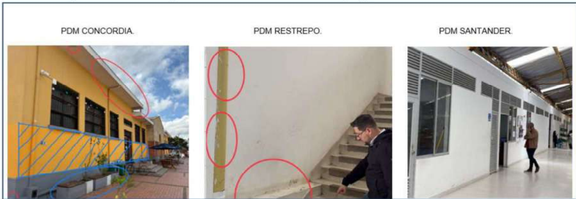
Figura 25. Labores de pintura identificadas en las visitas programadas.
