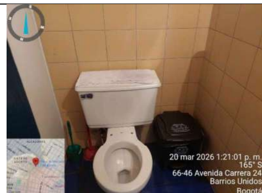
Fotografía No. 2. Cisternas convencionales
